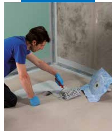
Aplicarea piesei de scurgere Drain Vertical pe stratul de Mapegum WPS
