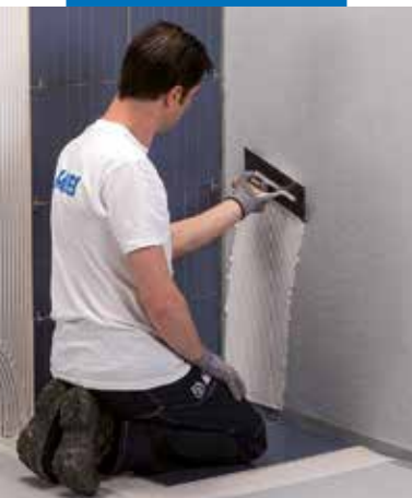
Montajul plăcilor ceramice cu adezivul Keraflex Maxi S1
