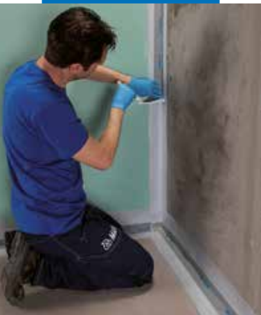
Aplicarea benzii Mapeband PE 120 folosind Mapegum WPS
