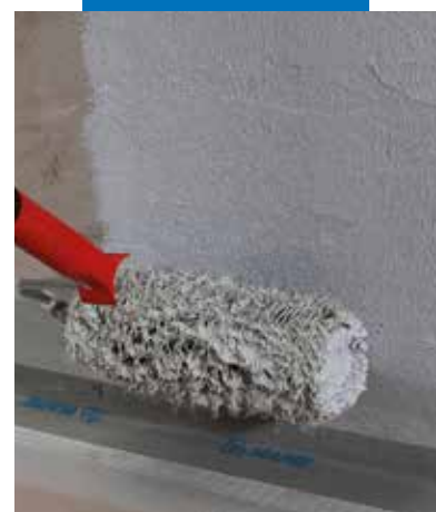
Mapegum WPS aplicat cu trafaletul
