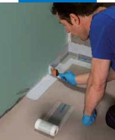
Aplicarea benzii Mapeband PE 120 folosind Mapegum WPS
