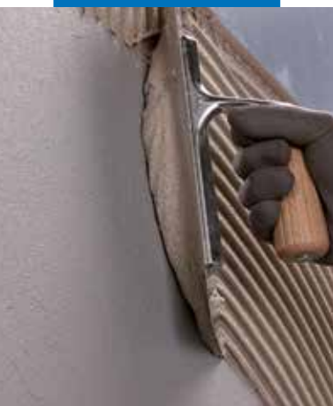
Montajul plăcilor ceramice cu Ultramastic III
