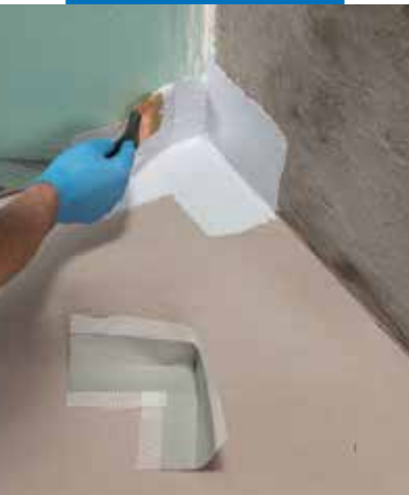
Aplicarea piesei speciale Mapeband PE120 pentru unghi de 90 folosind Mapegum WPS
